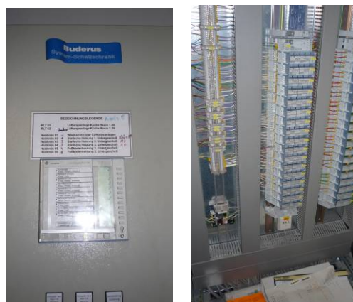
Bild: ISP 03 / Kasematten-Restaurant Controller UNIGYR PRU 2.128
