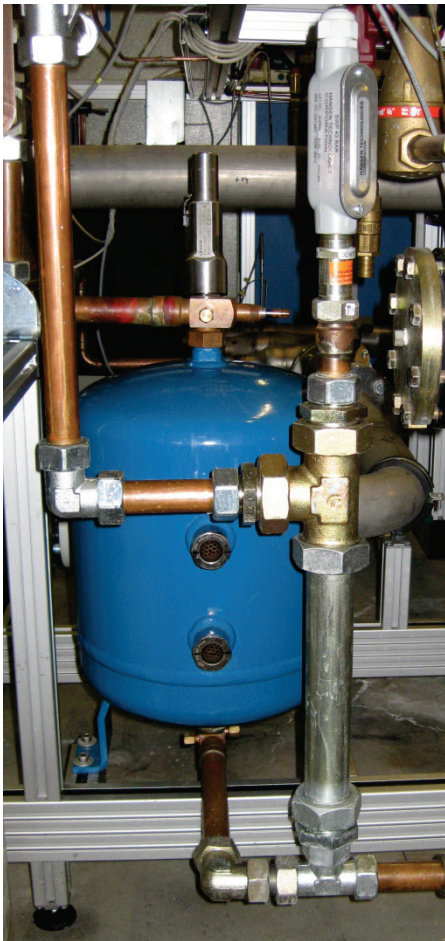
Bild 2: Füllstandssonde am Sammler
