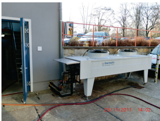
Bild 2: Verdampfer für die Quelle Luft
