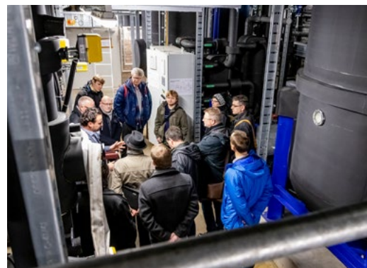
Bild 1: Besichtigung des Vakuumeis-Kältespeichers im Gebäude der Fakultät für Chemie der Georg-August-Universität Göttingen
