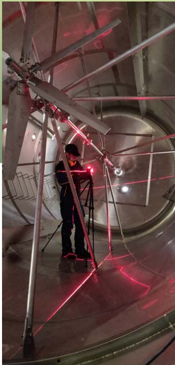
Bild 2: Innenansicht des Flüssigeisspeichers (hier noch liegend) während der Montage der Einbauten.
